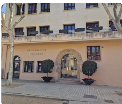
REFORMA EDIFICIS MUNICIPALS 100.000€
