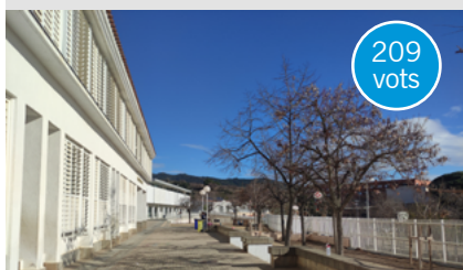
Transformem l'Escola Fabra
