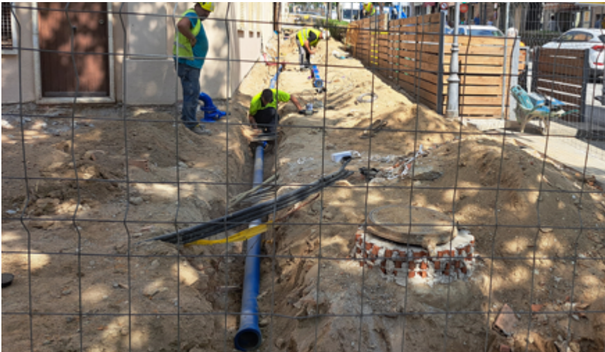
Les obres inclouen la substitució de la xarxa d'abastament d'aigua potable.
