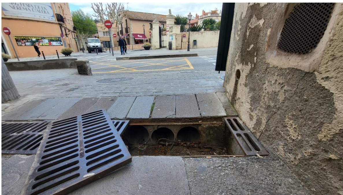
Fig 12. Reixa transversal a la confluència del carrer del Gurri amb la rambla d'Àngel Guimerà.
