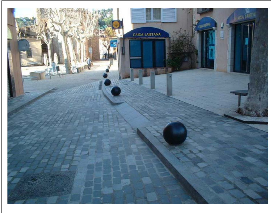
Foto 29. Rebaixament de voreres.
