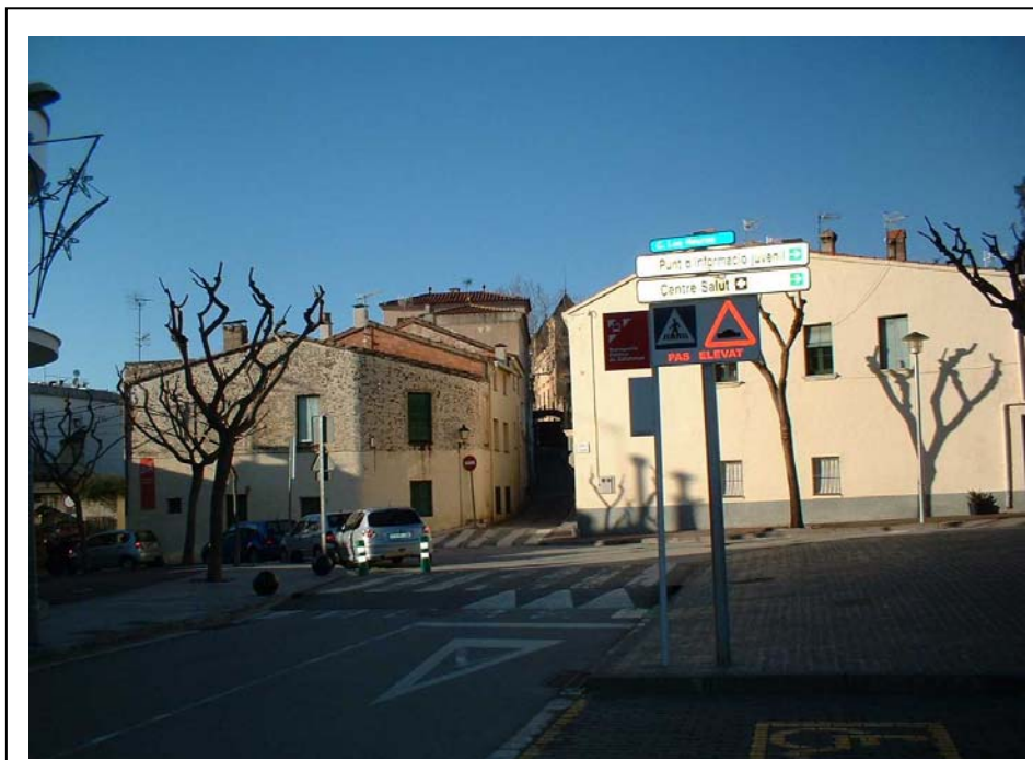
Foto 27. Pas elevat per pacificar trànsit, c/ de Les Heures.
