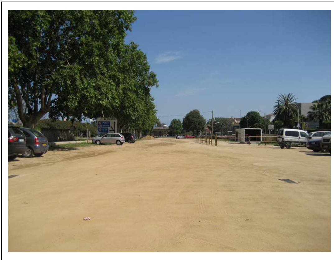
Foto 13: vista general de la riera d'Alella. Zona canalitzada
